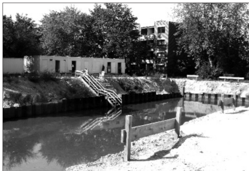
Wegen des monatelangen Baustopps hatte sich im Bodentrichter zwischenzeitlich ein Teich gebildet
